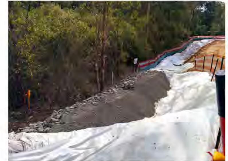
PHOTO 1: ROCK FILTER DAM EXAMPLE
